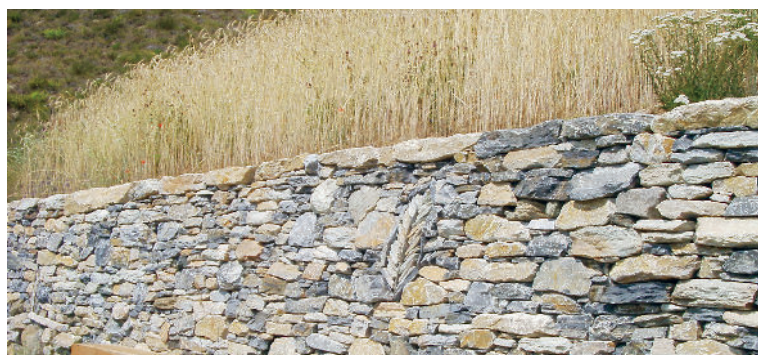
Natursteinmauer in Erschmatt.
